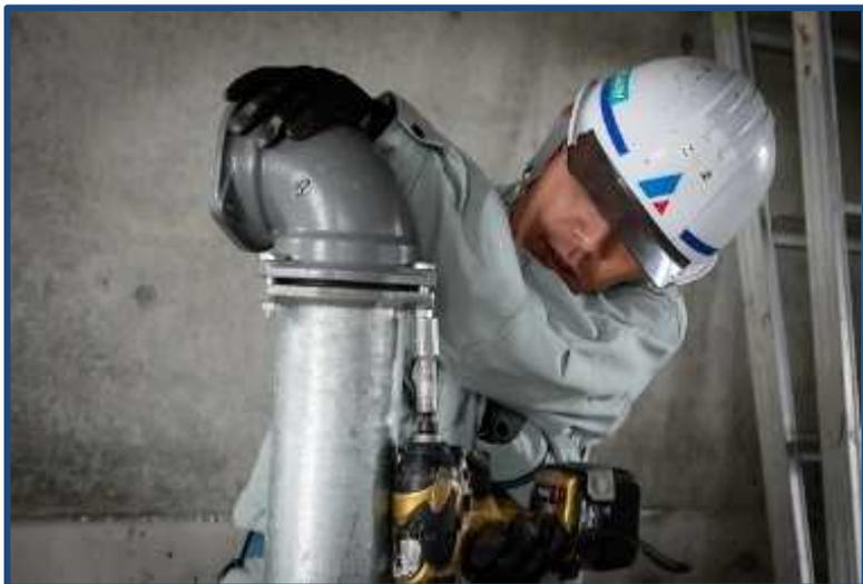
エアコン等の空調設備、流し台、トイレ等の給排水設備の設置、配管工事をします。資格がなくてもできる作業ですが、現場の責任者になるためには、資格が必要になります。
